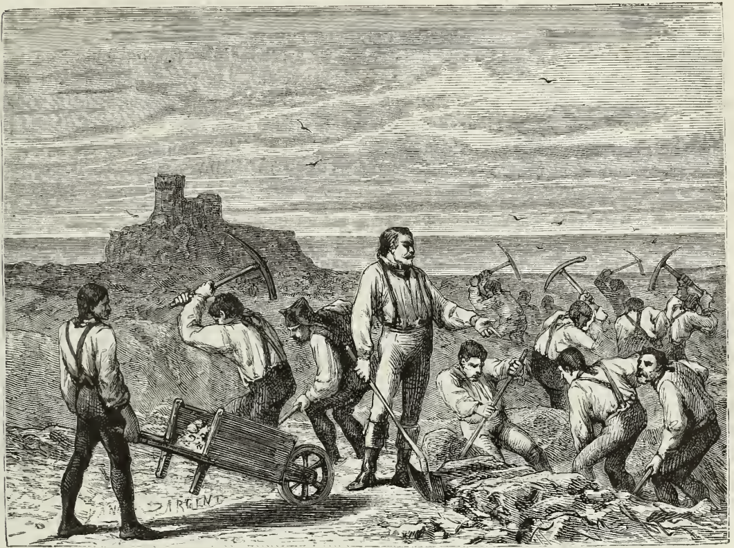
Je les voyais manier la pioche, et hâter les travaux. (Page 272.)
